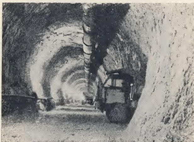
Sl. 2: Pogled na sam tunel
